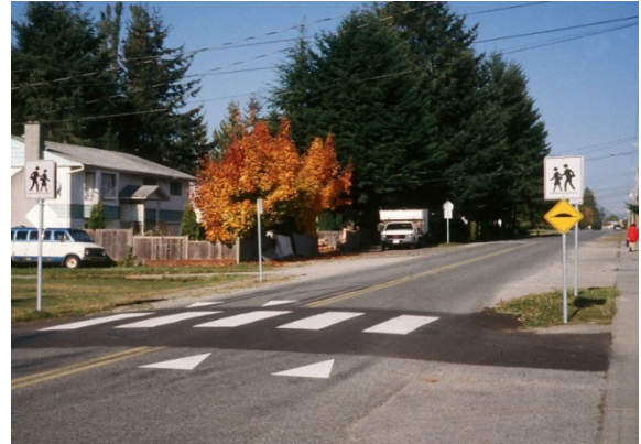
Figure 1 Une traverse piétonne surélevée en Colombie-Britannique
